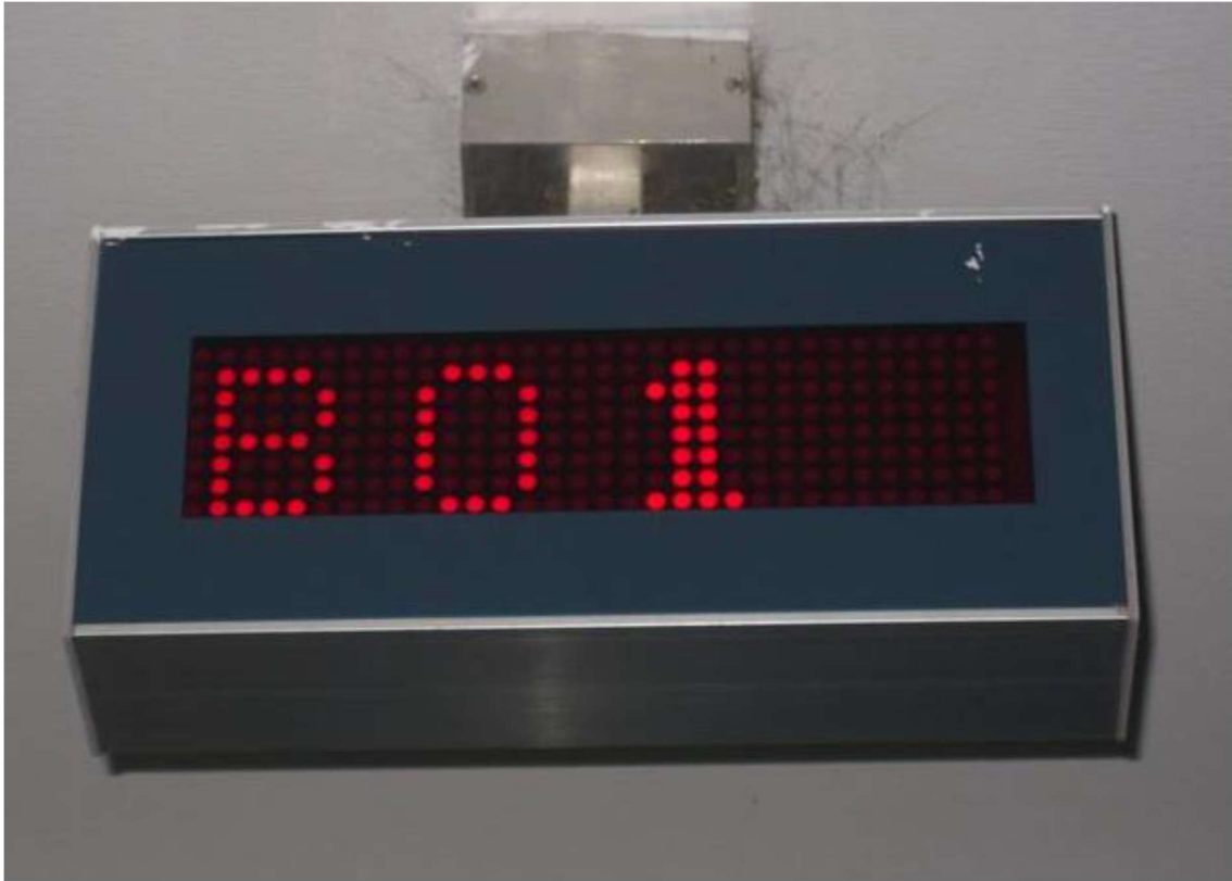
ภาพที่ 4.5.8 ป้ายแสดงตำแหน่งเตียง (Corridor display)
