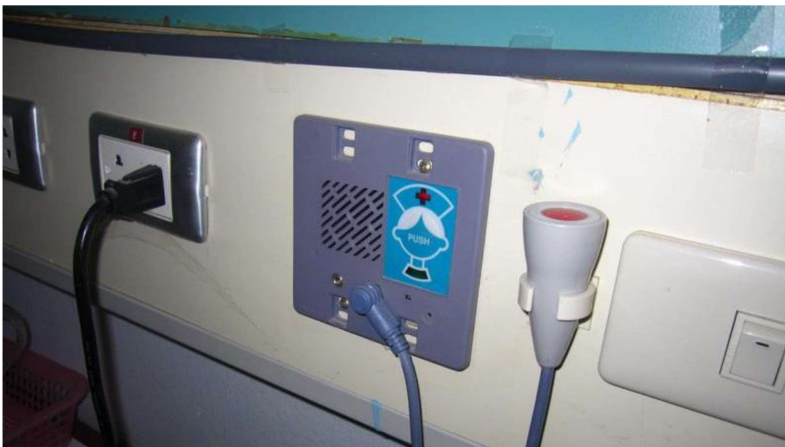
ภาพที่ 4.5.2 สวิตช์ฉุกเฉินหัวเตียง (Bedside call panel)
